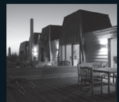
SANIERUNG IM BESTAND
