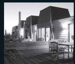
SANIERUNG IM BESTAND
