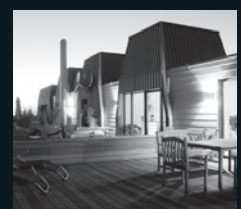
SANIERUNG IM BESTAND
