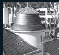
SANIERUNG IM BESTAND
