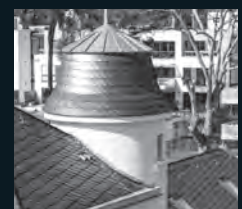
SANIERUNG IM BESTAND
