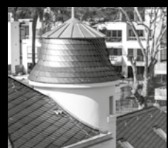
SANIERUNG IM BESTAND
