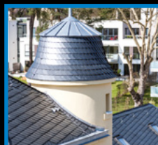
SANIERUNG IM BESTAND
